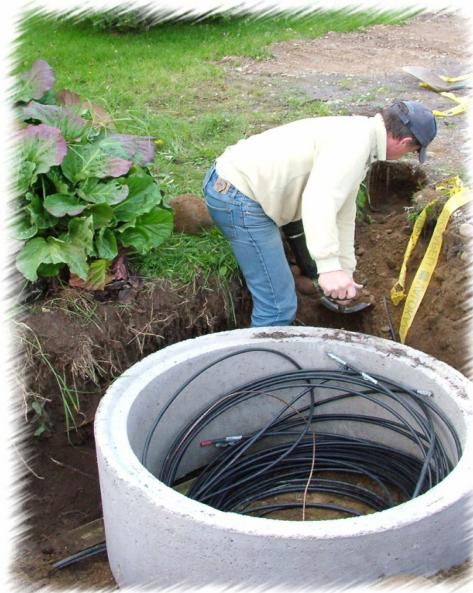
Arauksen jälkeen maastoon asennettiin yhteensä 10 betonikaivoa, joihin liityjiltä tulevat kaapelit myöhemmin hitsattiin.
